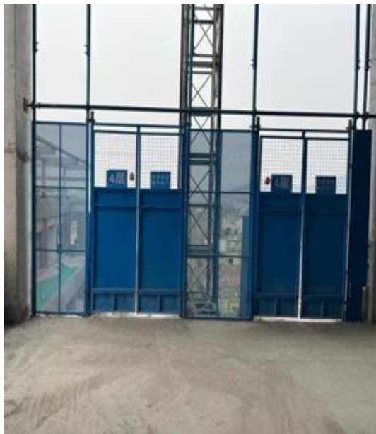
楼层平台侧面防护
