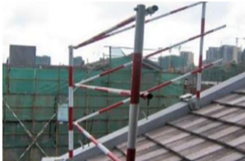
斜屋面周边临边防护
