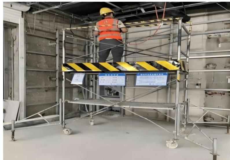
门式钢管脚手架防护
