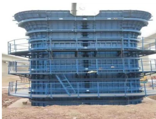
桥梁墩柱钢模板操作平台
