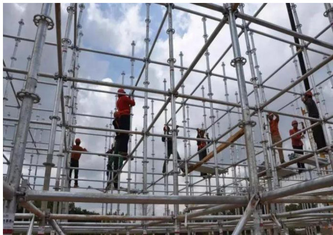
盘扣式脚手架高支模安拆作业
