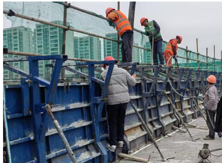
护栏浇筑时临边防护系统
