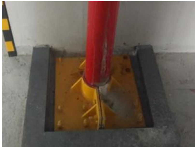
放线孔、传料口、泵管口等防护
