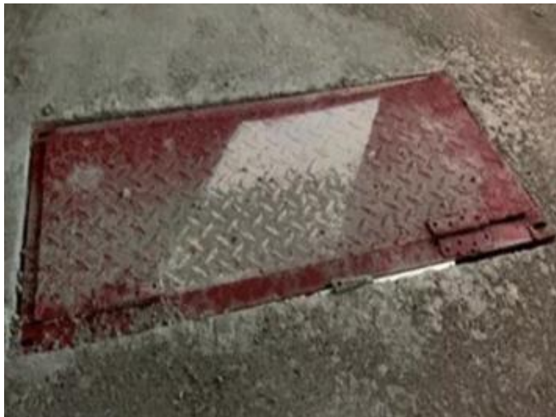
放线孔、传料口、泵管口等防护
