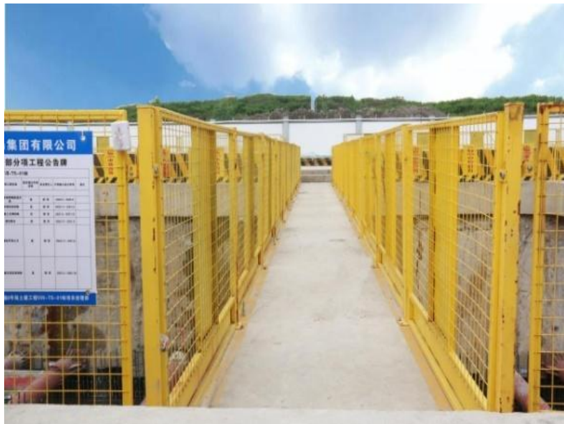
有通行需求内支撑临边防护
