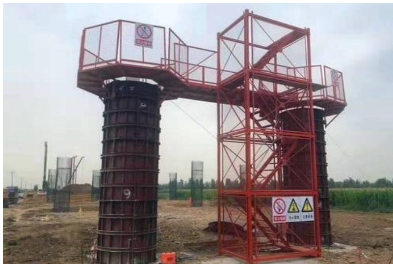
墩柱模板一体式梯笼
