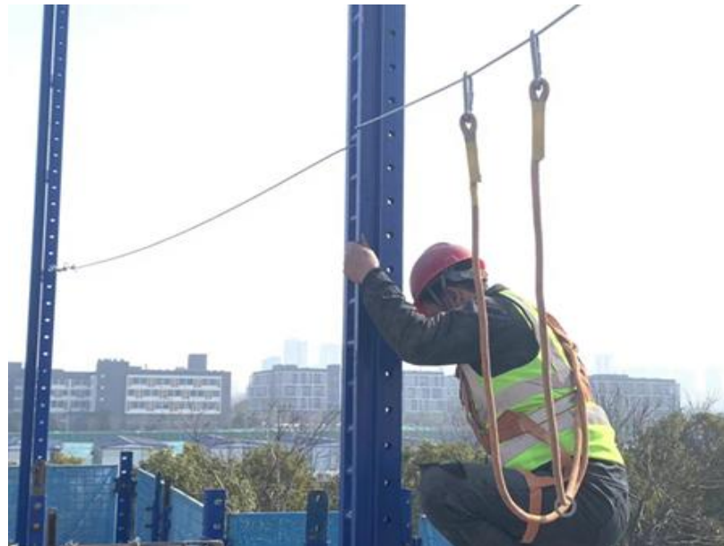
拼装、安拆作业
