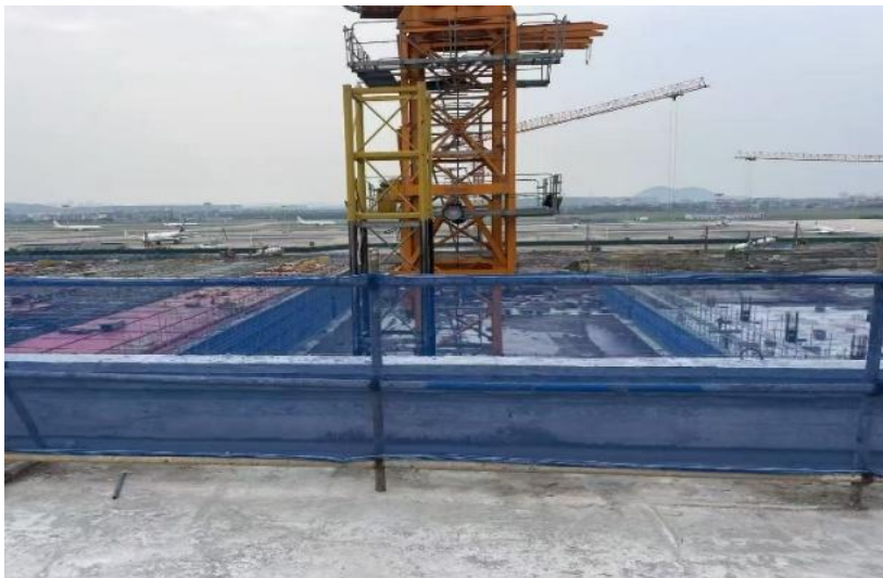
水平屋面周边临边防护
