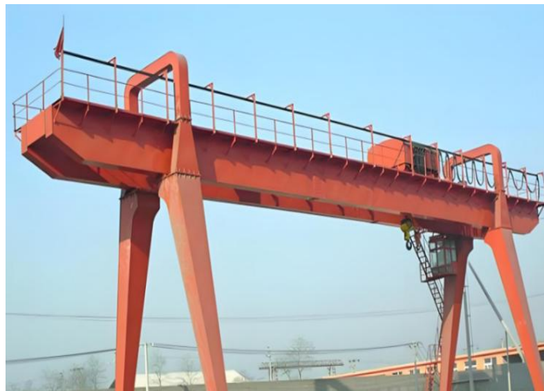
上横梁临边防护
