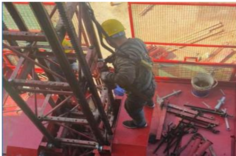
安拆作业安全带系挂
