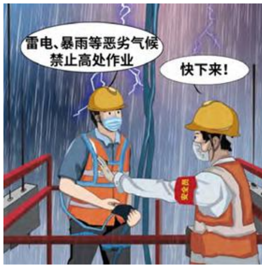
雷电、暴雨天气，不得进行高处作业
