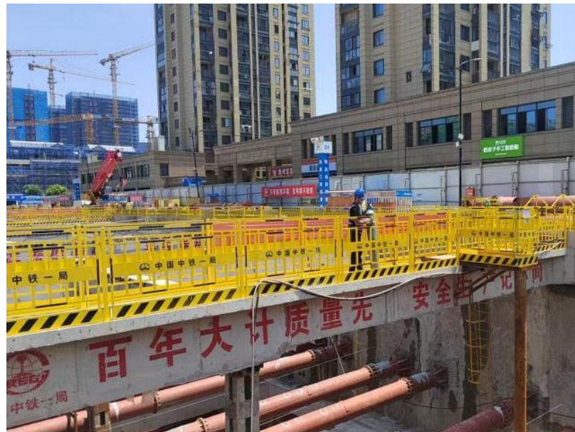
有通行需求内支撑临边防护
